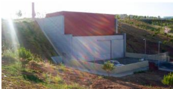
Illustrasjon 6: Eksempel fra Spania hvor avfallssugterminalen er plassert delvis inn i terrenget
