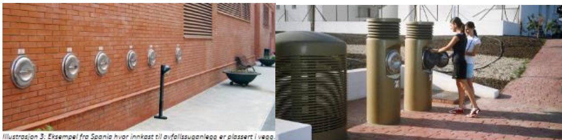
Illustrasjon 3: Eksempel fra Spania hvor innkast til avfallssugeanlegg er plassert i vegg.
