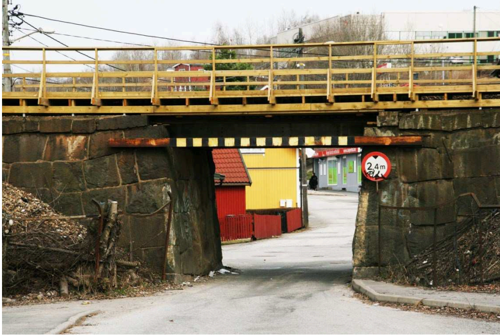
Figur 7 - Undergang for kjøretøy under jernbane på Greåker
