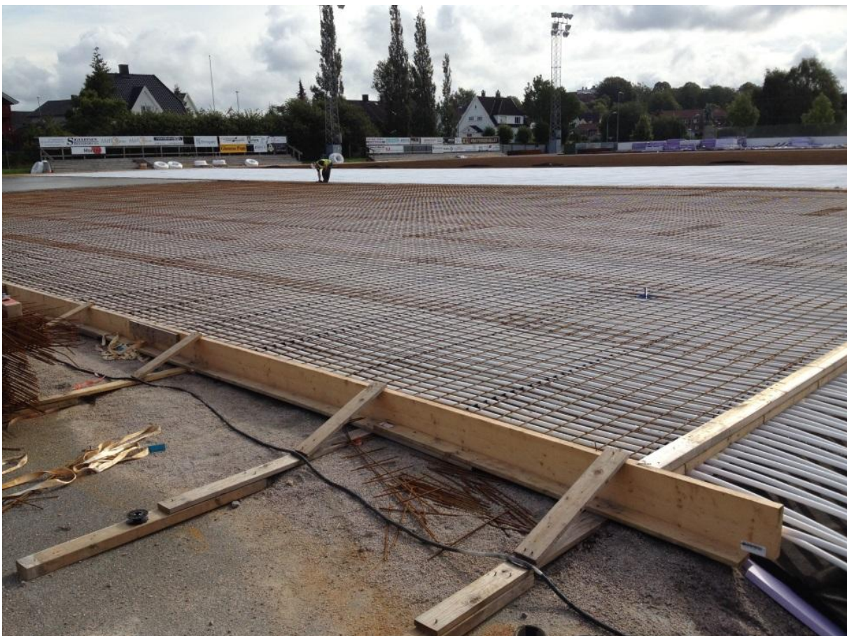
Rehabilitering av kunstisbanen høsten 2016 . Her legges kjølerør og armeringslag nr 2.
